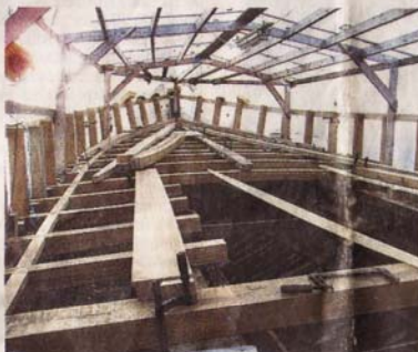
Das Deck: Die Restaurierung wird nach traditioneller dänischer Schiffsbaumethode betrieben. Auch der Innenraum wird nach historischem Vorbild ausgestattet.
